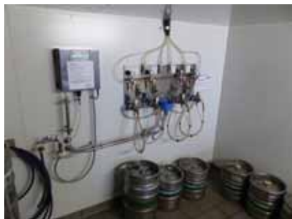
Abb. 9: Automatisches chemisches Reinigungsgerät für Leitungen (Dosiervorrichtung und Steuereinheit)
